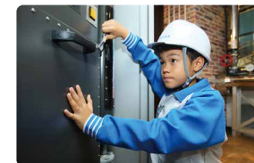
甲 ボイラ施設
